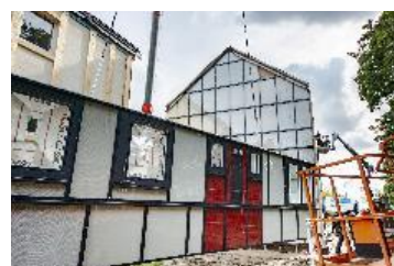
Quelle: Tamara Pribaten/dena
