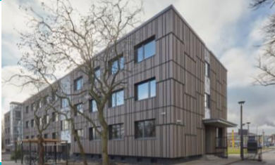
Verwaltungsgebäude Tierpark, Berlin ZRS Architekten Ingenieure; Zimmerei Sieveke
