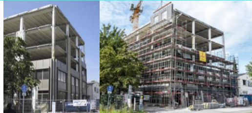
Bürogebäude Frankfurter Ring, München
